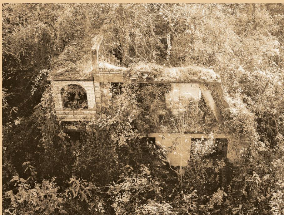
Opština Teočak, devastirana romska kuća u naselju Jasenje
